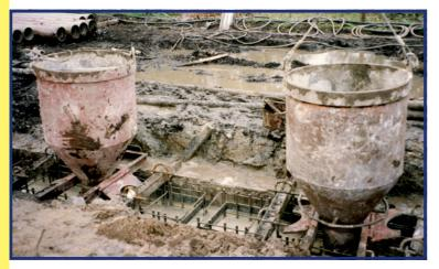
Schüttrohre und Zubehör zum Einbringen von Beton in den offenen Schlitz oder artverwandte Aufgaben.
